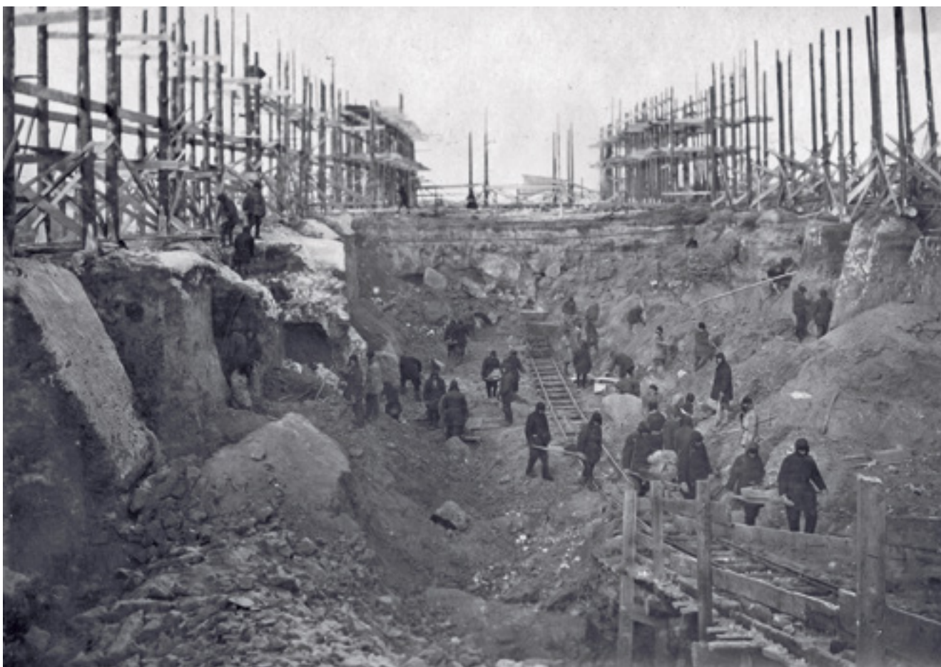
Строительство реактора «А».
