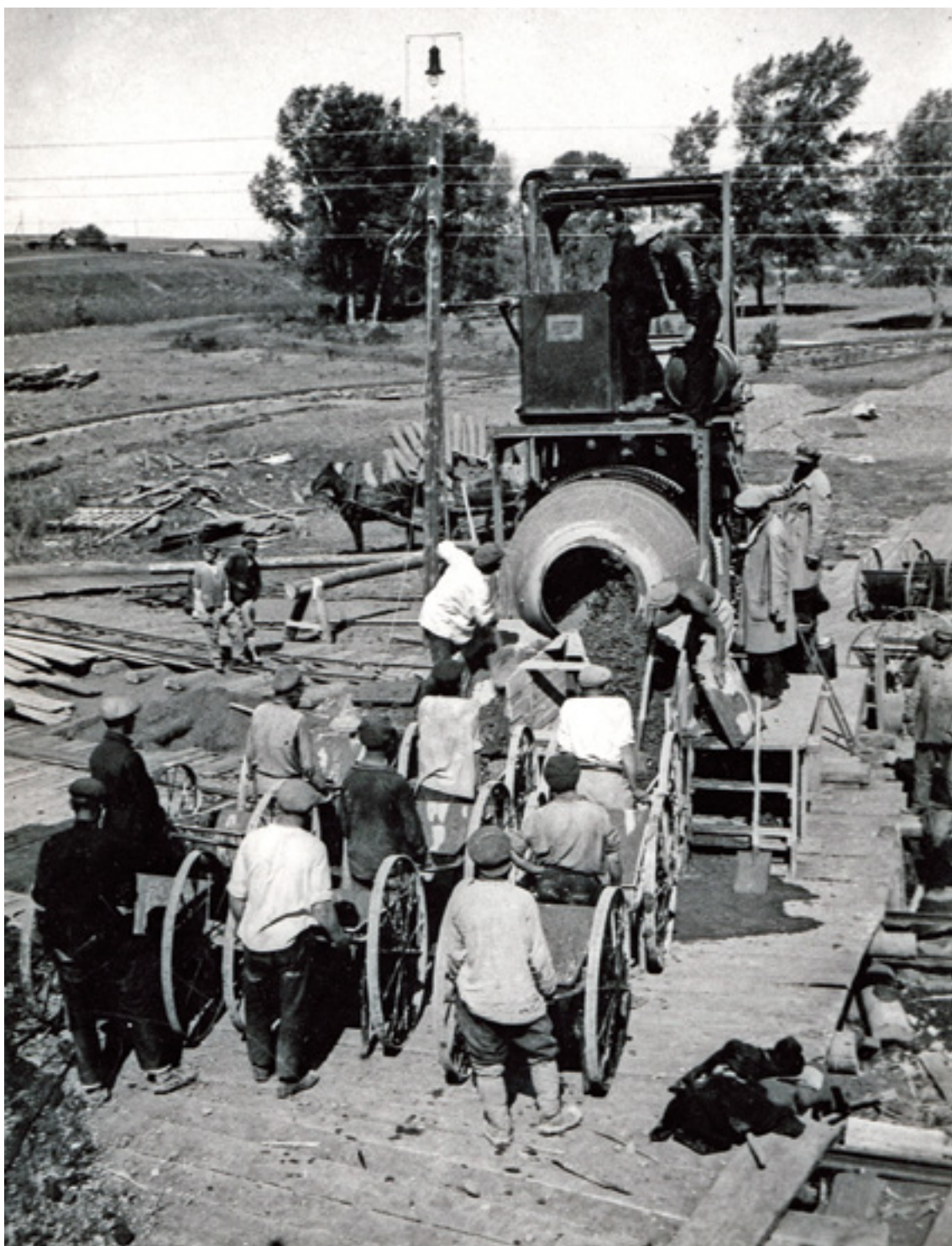
Бетономешалка на правом берегу плотины
