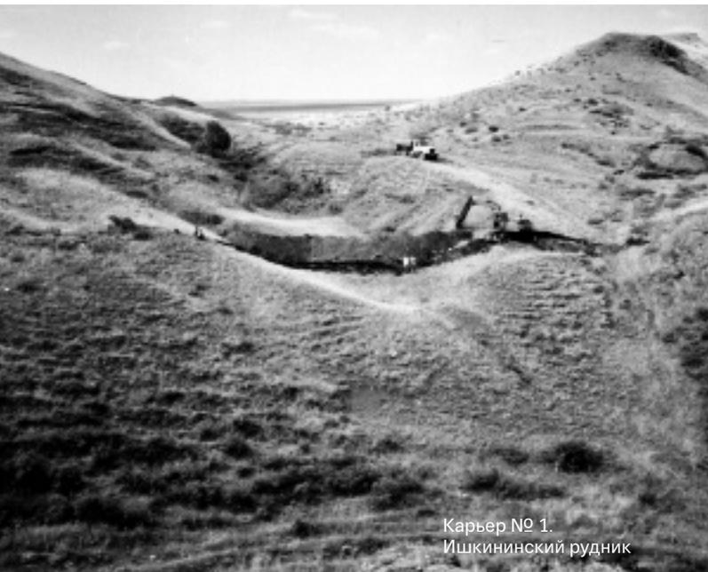
Верхняя часть северного отвала вскрыта на глубину 3-5 метров траншеей № 3. Отвал сложен дресвяно-щебнистым материалом, слои которого залегают кулисообразно. Разрез отвальных отложений включает три горизонта, различающихся как по минералого-петрографическим особенностям слагающего их материала, так и по величине обломков. Нижний и средний горизонты разделены погребенными почвами, что свидетельствует о длительных перерывах в разработке рудника.
